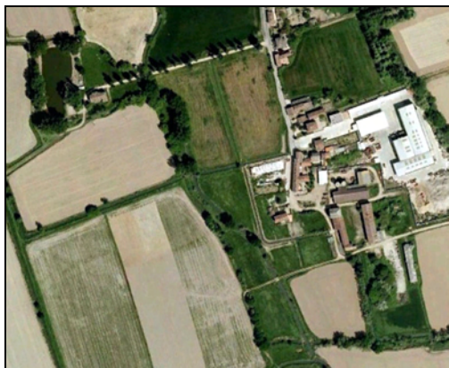
Figura 31. ATSPr-PR 1. Foto aerea
